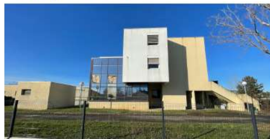
Vue façade est
