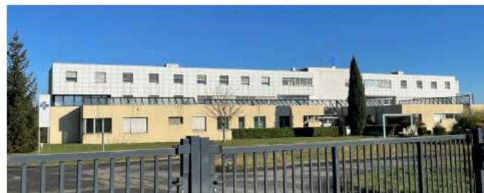
Vue façade sud
