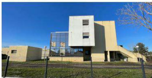
Vue façade est
