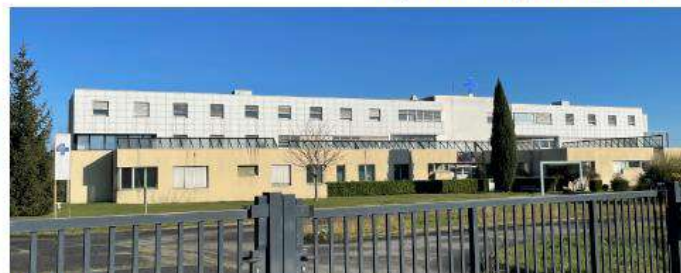
Vue façade sud
